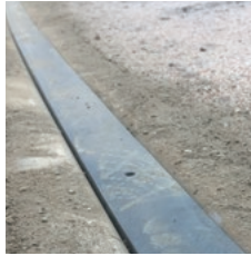
養生後の様子
